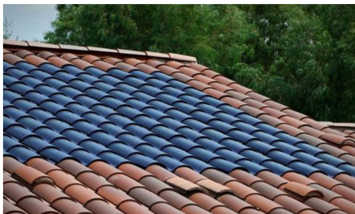
Couverture en tuiles photovoltaïques ou solaires autorisée.
