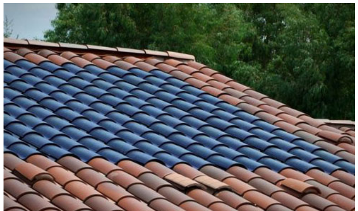
Couverture en tuiles photovoltaïques ou solaires autorisée.
