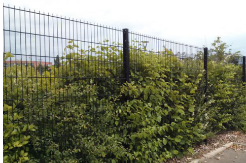
Exemple de clôture grillagée de type Panneaux Rigides RAL 7016 doublée de haies
