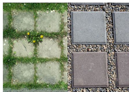
Exemple de revêtement perméable aux eaux de pluies (pavés en pierres, pavés bétons avec joint perméable)
