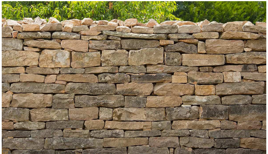
Exemple de traitement sur rue réalisé par l'aménageur à maintenir durablement // parement en pierres calcaires.
