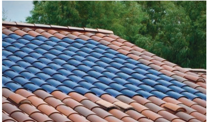
Couverture en tuiles photovoltaïques ou solaires autorisée.
