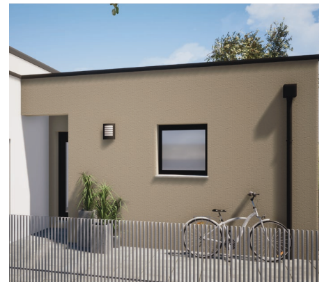
Enduits de façade
