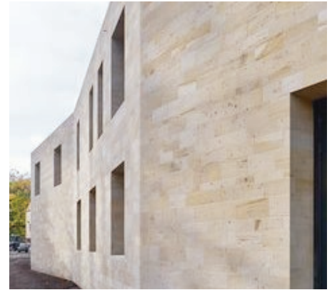
Mur en pierres
