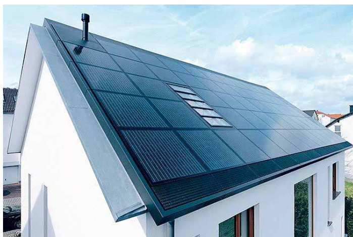
Couverture photovoltaïque.
